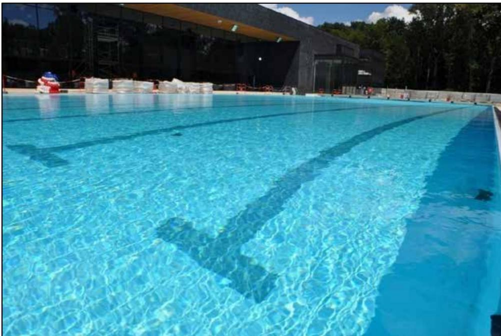
Les travaux de construction du Centre aquatique intercommunal de Paris - Vallée de la Marne, à Champs-sur-Marne, sont dans leur dernière longueur. Après la pose du revêtement de façade et des carrelages intérieurs, c'est au tour du bassin extérieur de 50 mètres d'être mis en eau pour tester son étanchéité.
